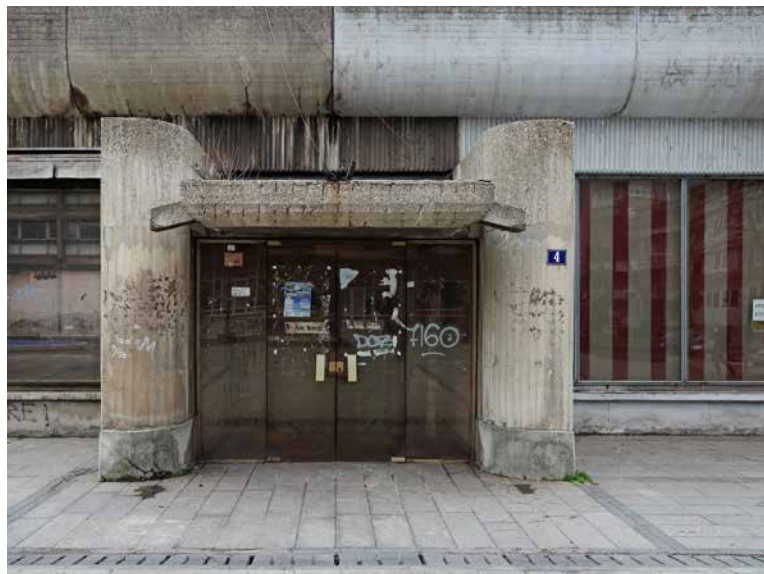
trenutno stanje objekta -glavni ulaz
