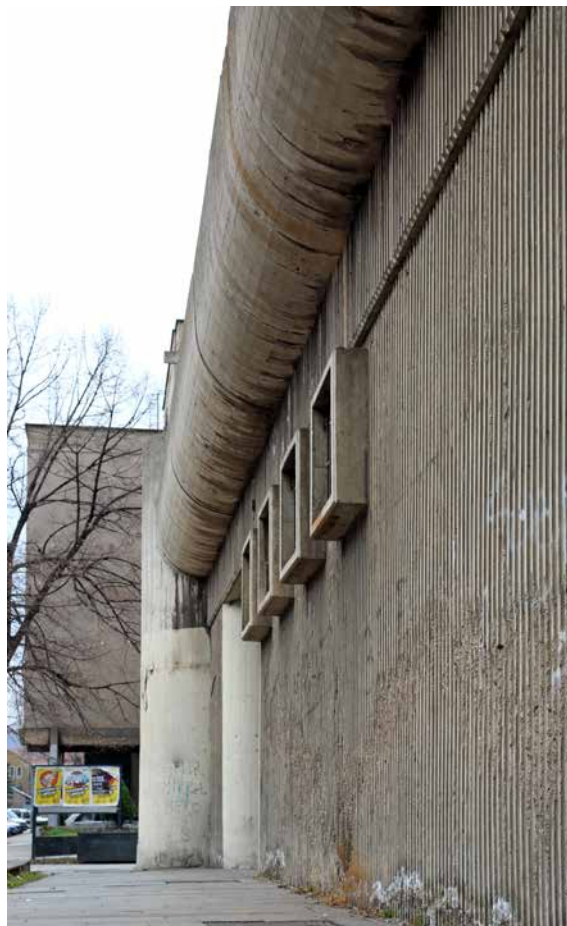
trenutno stanje objekta -tretman fasade
