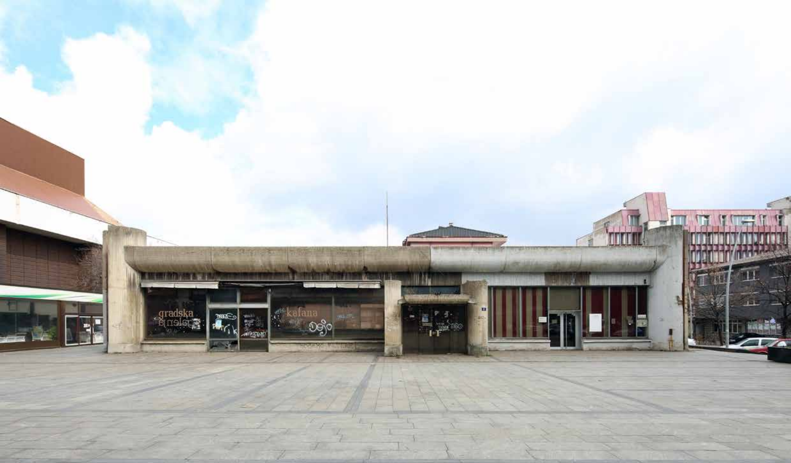
trenutno stanje objekta - ulazna fasada
