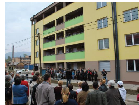
Slika 13. Nedavno završeni projekat utopljanja
